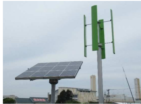
ふなばし三番瀬環境学習館に設置される風力発電設備と太陽光発電設備
