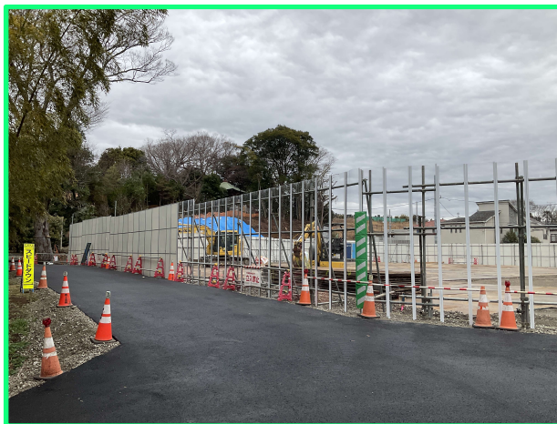
■都市計画道路 3・4・27 号線（橋梁工事付近）
