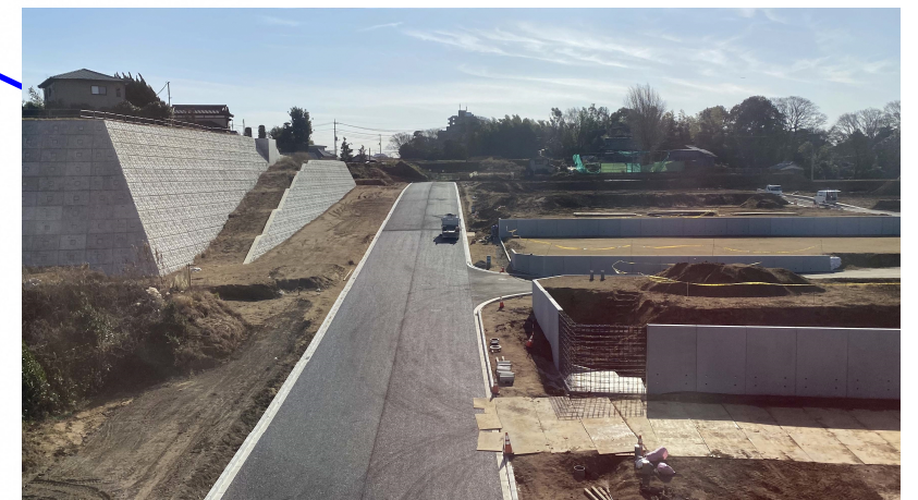
■ 飯山満駅南側の工事の状況（都市計画道路3・4・27号線周辺）
