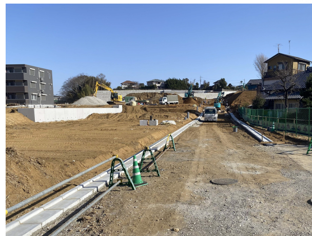
■ 12街区付近の工事の状況
