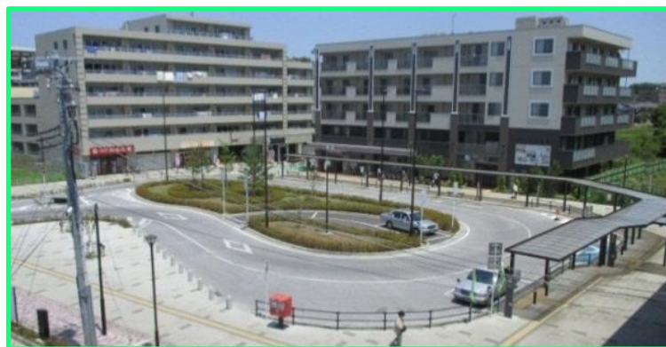
■飯山満駅前交通広場（平成25年4月竣工）
