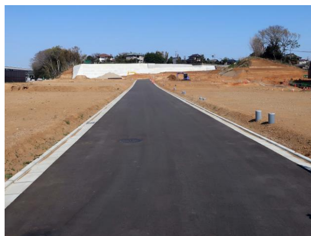
■10街区・12街区付近（道路整備等完了）
