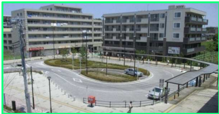
■飯山満駅前交通広場（平成25年4月竣工）
