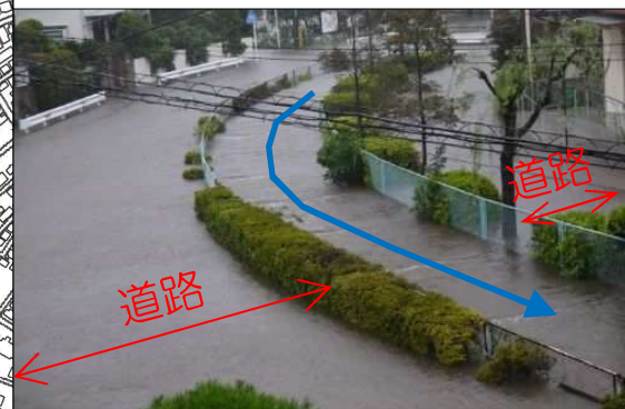
② 西習志野3号公園付近（西習志野1丁目）
