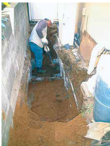
① 穴を掘り配管の準備をします。
