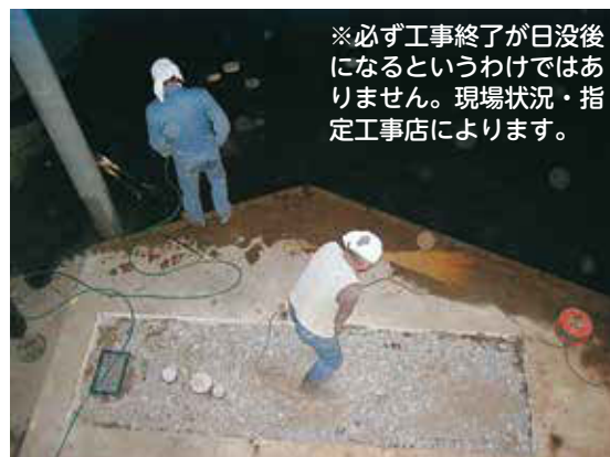
④ 底部に穴開けし、埋め戻します。
