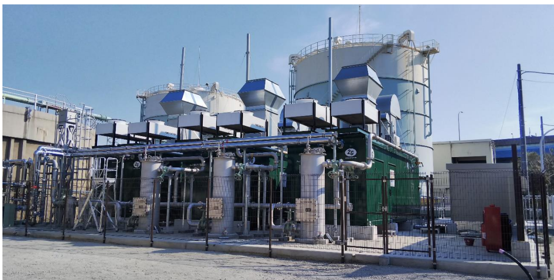
図4 西浦下水処理場消化ガス発電機
