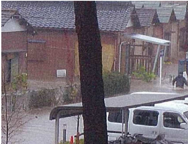
状況写真: 浸水箇所
