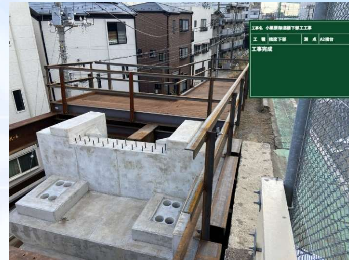
南側 A2橋台
