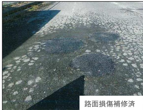
路面損傷補修済
