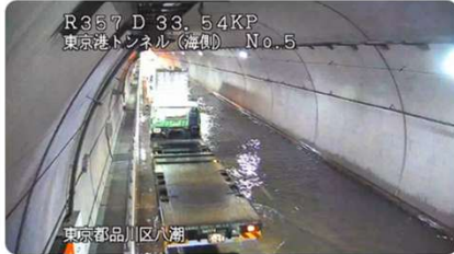
国道357号東京港トンネル通行止めの状況
