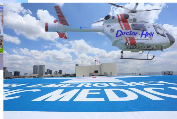
屋上ヘリポート
