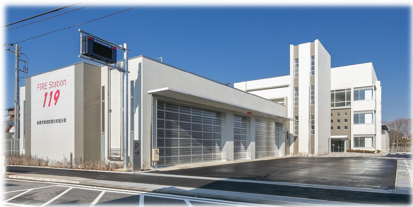
東消防署古和釜分署
