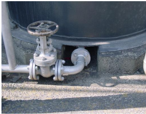
写真2 水抜管を底板に設けた例
