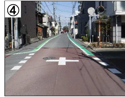
④ 交差点、路肩部カラー舗装
