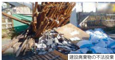
建設廃棄物の不法投棄
