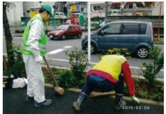
【杭打ち・ロープ張り】
