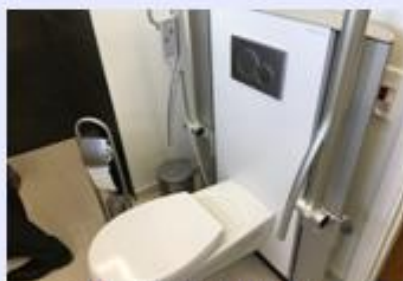
床暖房、上下の移動が可能な便座
