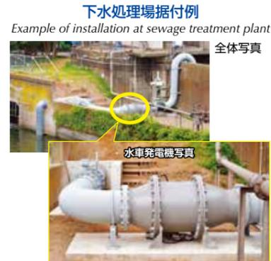
水位3～10m程度の落差で発電するインライン型水力発電機。水量により1.5kw～10kwの発電が可能となる。インライン型のため、水平・垂直でも設置が可能。上下水道や水を多く使用する食品工場や製紙工場等の排水を利用して発電している。
