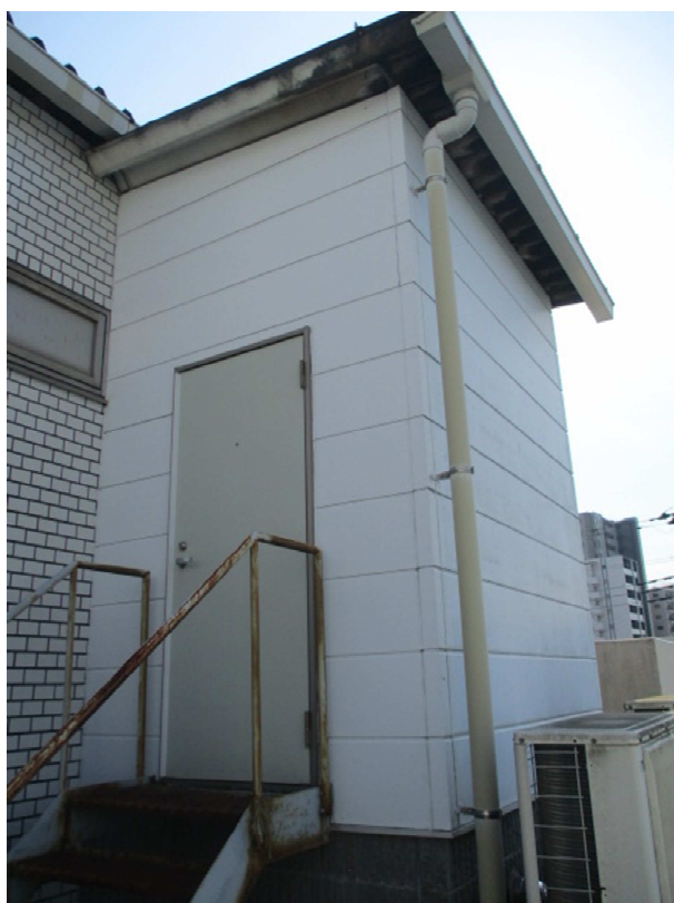
(北側 陸屋根 機械室)
