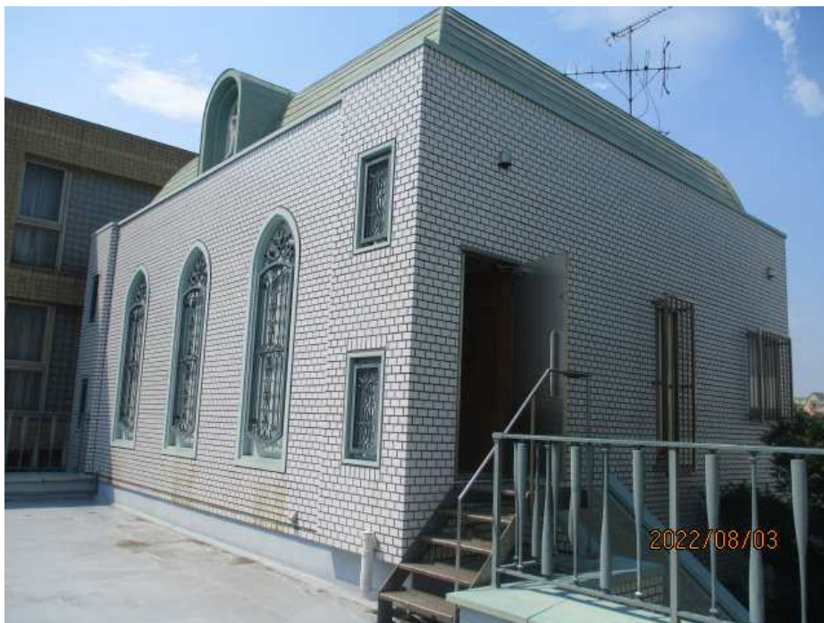
(南側 陸屋根から撮影した2階部分)
