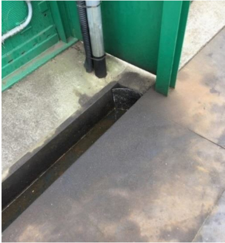
(左：ヤード周辺に排水溝を設置、右：油水分離槽の設置)
