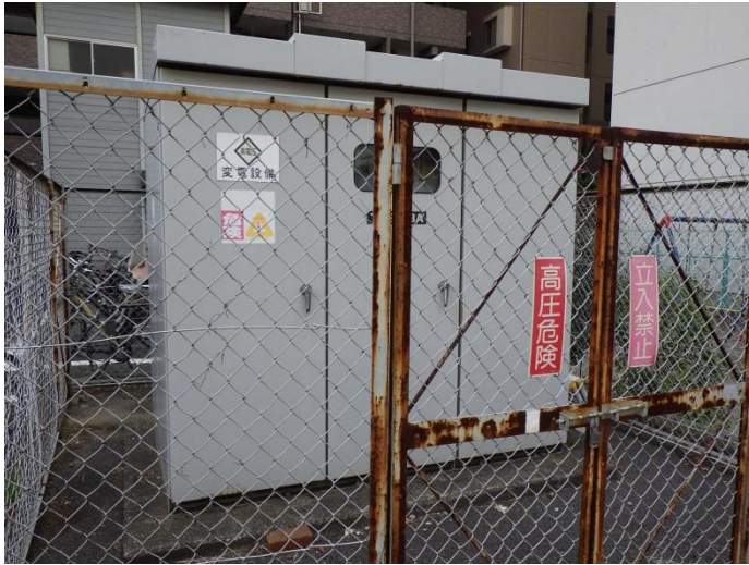
キュービクル式高圧受電設備 (建物の屋上に設置されているケースも見られる)
