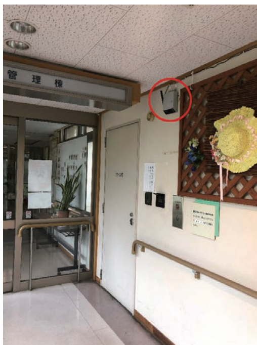
入居フロアの出入口に設置
