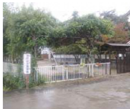
<施設外観(正面入口)>
