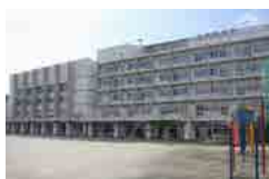
船橋小学校外観
