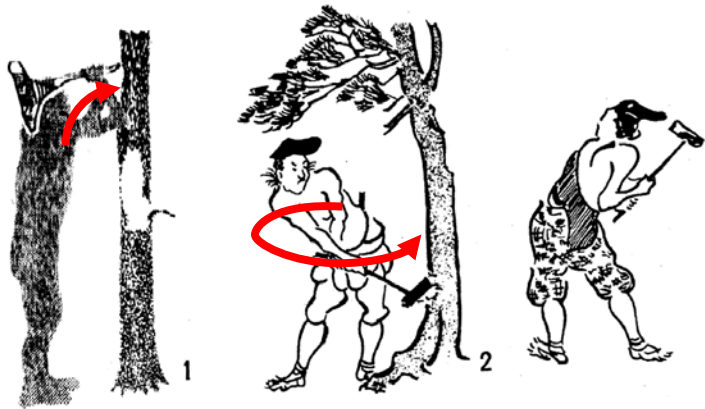
1 横斧による伐採 2 縦斧による伐採(『石山 寺縁起絵巻』より)
