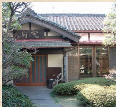
▶第一別館。昭和3年(1928)建築の平屋建て
