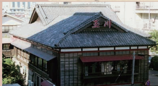
▲第二別館。昭和8年(1933)建築の2階建て
