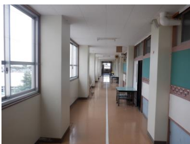
「夏休み中の内壁工事」 3～5Fの廊下や西階段の壁がきれいになりました。
