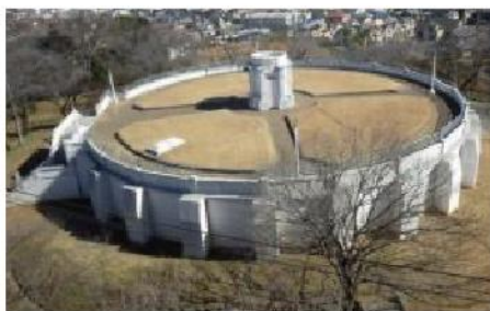
千葉分場1号配水池 (千葉市)
