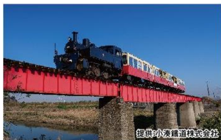
小湊鉄道第一養老川橋梁 (市原市)
