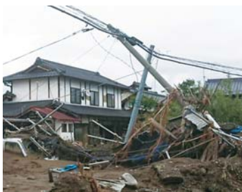
平成30年7月豪雨時の避難所の状況
