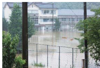
平成30年7月豪雨 指定避難所の学校の浸水状況
