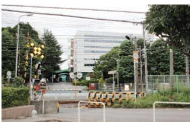
近隣住民に配慮した解体工事の指導を
