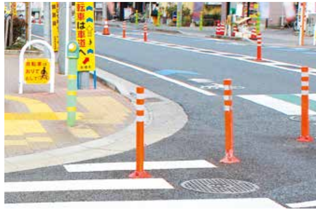
歩道等に設置されている柵やポール
