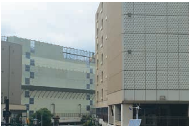
左：解体工事中の旧ロフト 右：旧西武船橋店
