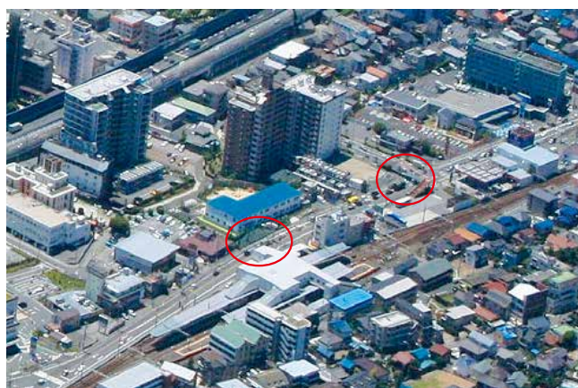
宮本町三丁目歩道橋の移設予定地(左の○)と既存の歩道橋(右の○)
