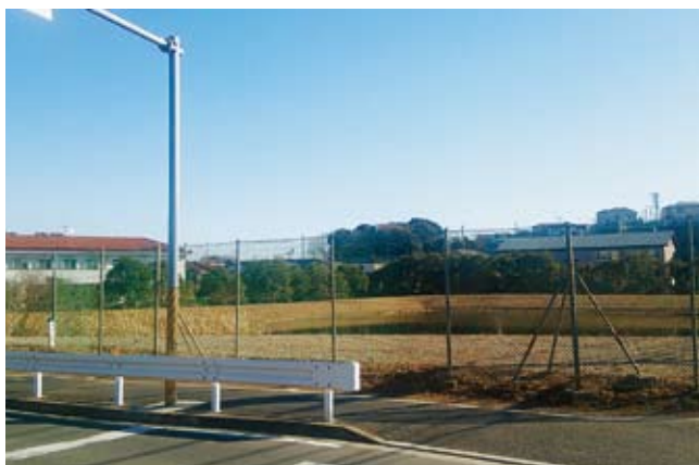
芝山東小学校の東側にある第1調整池
