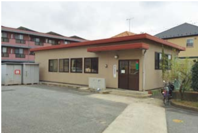
法典西小学校敷地内にある法典西放課後ルーム
