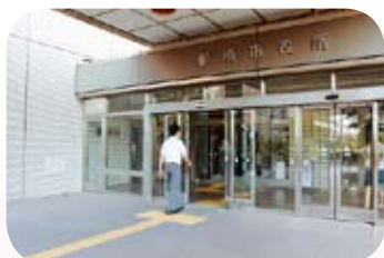
1. 市役所本庁舎入口
