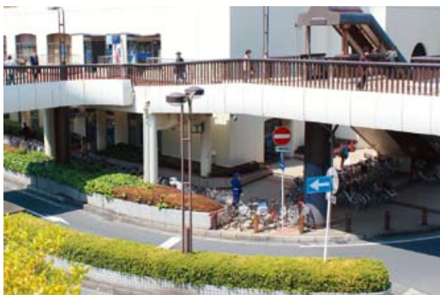
JR船橋駅北口広場エレベーター設置予定箇所
