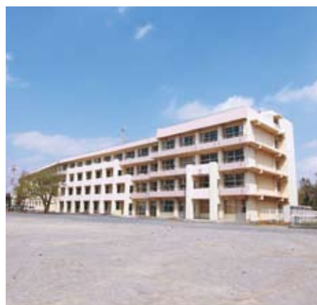
耐震化が完了した校舎
