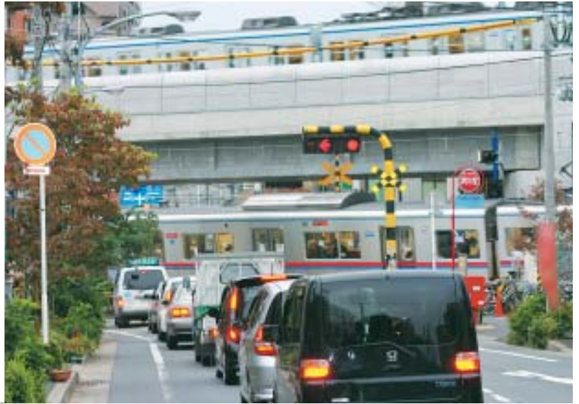
完成間近の京成本線連続立体交差事業
