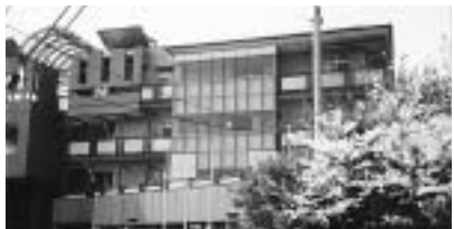
導入するパワーリハビリセンター
