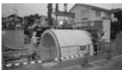
環境行政の推進を(下水道工事)
