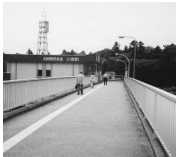
屋根・側壁の設置を(小室駅の跨線橋)
