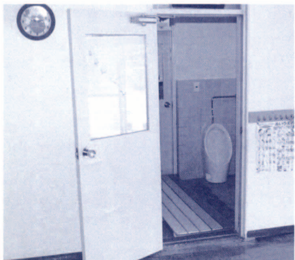
補修された保育園のトイレ
