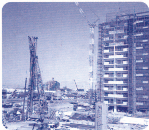
まちづくりを問われる高層マンション建設
