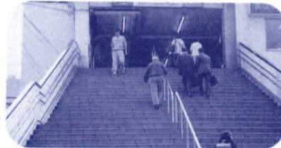
バリアフリー化がのぞまれる西船橋駅北口外階段
