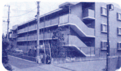
避難通路の確保を(飯山満町の借上市営住宅)
