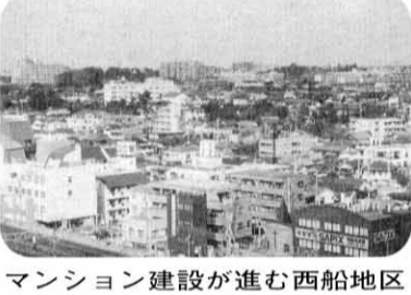
マンション建設が進む西船地区
