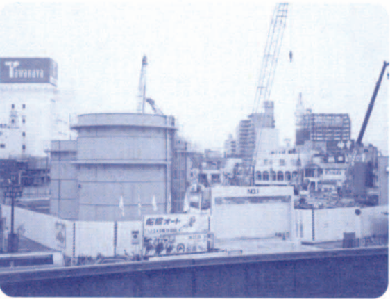
多面的に活用が期待される建設中の南口再開発ビル
