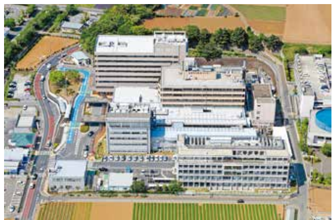
狭隘化による増築で構造が複雑化した現医療センター
