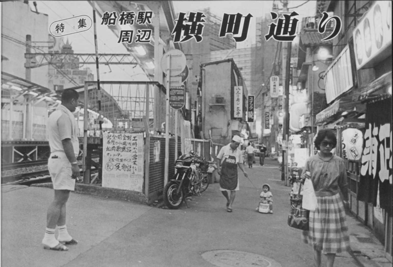
京成船橋駅の西側、稲荷横町とその周辺路地には多くの居酒屋、飲食店などが立ち並び。夕暮れ時をむかえそろそろ活気も出はじめる頃。
